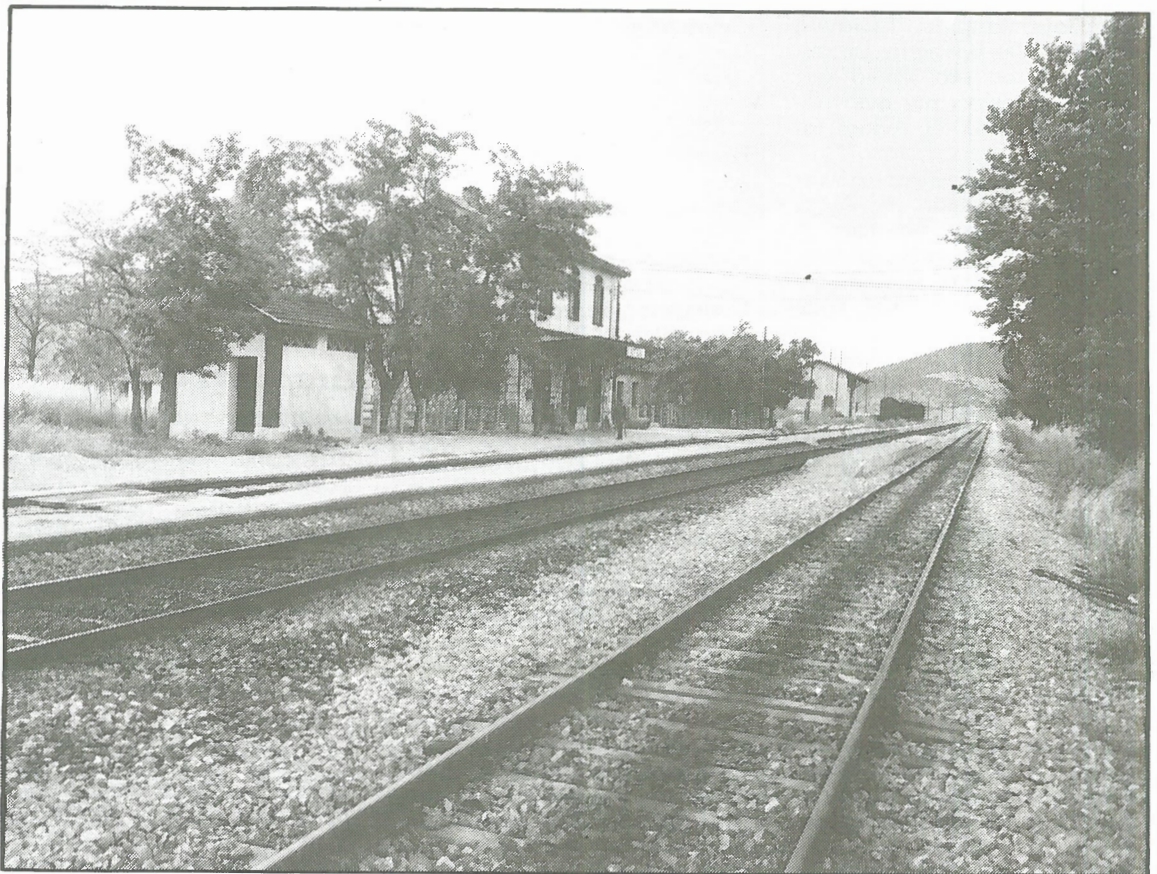
Ο Σιδηροδρομικός Σταθμός Αγγειών, που λειτουργεί από τον περασμένο αιώνα και εξυπηρετεί όλη την περιοχή.
